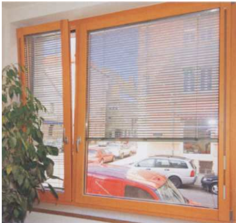
ペアガラスやトリプルガラスを用いた断熱/気密に優れたウッドサッシ
